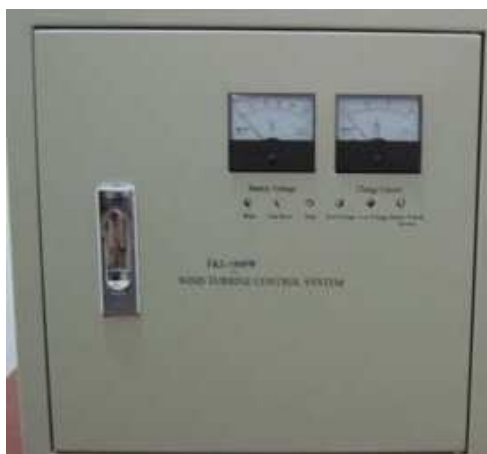
Figura 2.18 Controlador de carga tipo outdoor.
