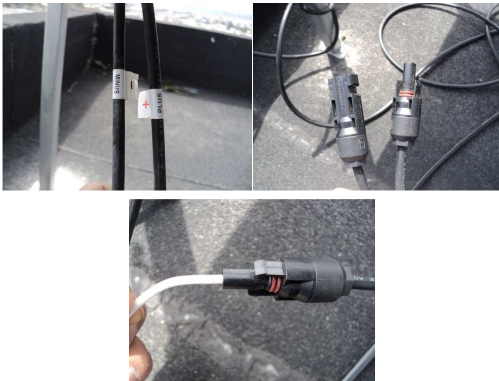
Foto 3.13 Conexión de los conectores y alambres.
