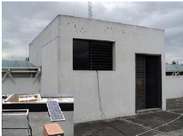
Foto 3.9 Cuarto de control del ascensor, terraza del edificio del ITSA.
