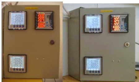
Figura 22: Visualización de voltajes y corrientes en analizadores de red
