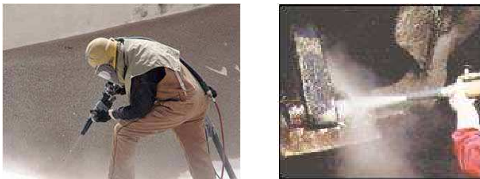
Figura 1. 1 - Aplicación de sandblasting
