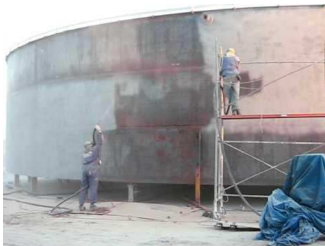
Figura 2. 13 - Resultados de sandblasting en tanques atmosféricos
