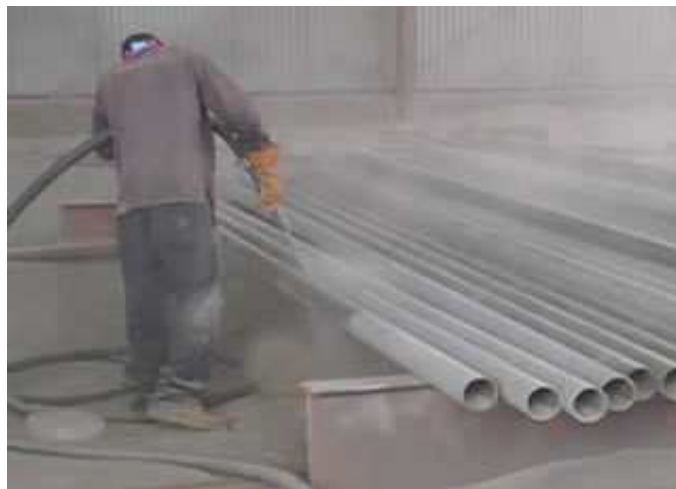
Figura 2. 12 - Resultados de sandblasting en tuberías
