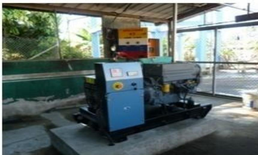
**Figura 1.5** Generador para el sistema del Agua Potable<sup>8</sup>
