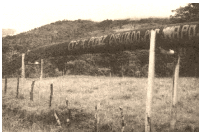
Figura 16: Destrucción de varios tramos del oleoducto Trans-Ecuatoriano
