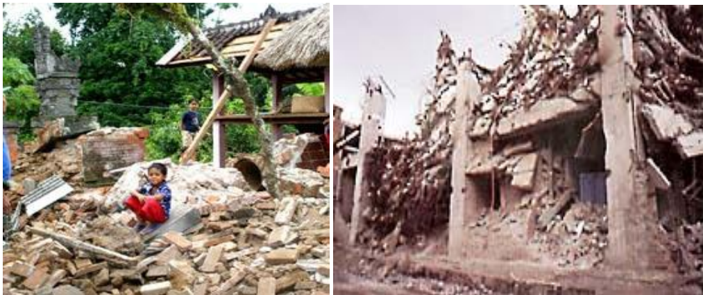
Figura 6: Destrucción total de viviendas
