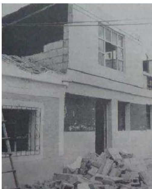
Figura 18: Vivienda de hormigón armado afectada por el sismo. Pomasqui
