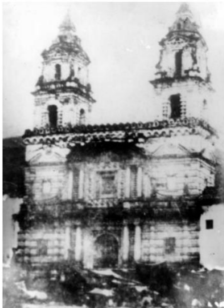
Figura 21: Daños registrados en la Iglesia de San Francisco
