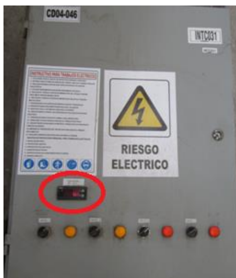
Figura 3. 10. Indicador de temperatura para los bancos de hielo
