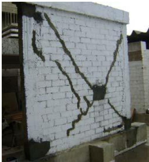
Figura 3.5 Muro reparado (Cortesía Ángel San Bartolomé)
