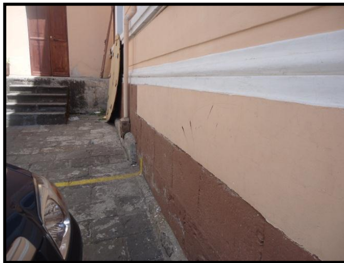
Figura 5.5 Muro de cimentación de roca.
