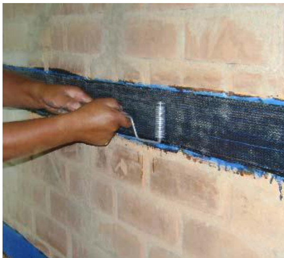
Figura 3.8 Aplicación de Mbrace Saturant (Cortesía de Ángel San Bartolomé)
