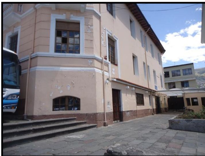
Figura 5.1 Fachada posterior Edificio Colonial Liceo Fernández Madrid.
