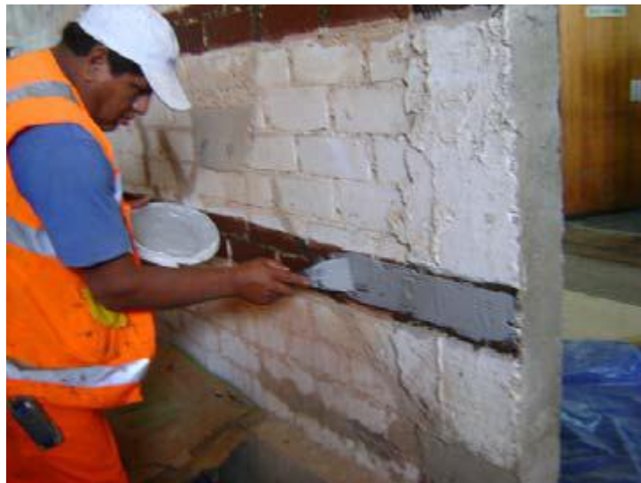
Figura 3.7 Aplicación del imprimante. (Cortesía Ángel San Bartolomé)
