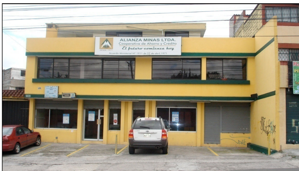
Figura 1: Fachada exterior de la agencia norte
