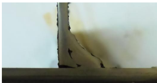
Centro Columna-Viga principal A (CC-VPA)
