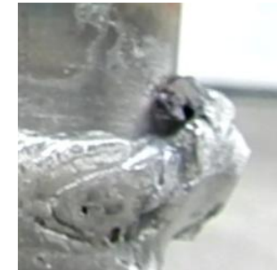
Norte SMAW Columna Extensión (Falta de fusión, perfiles de soldadura)
