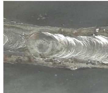
SMAW Viga principal (Cráter)
