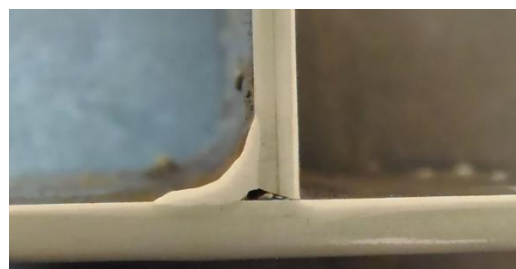
Norte Viga Principal-Viga secundaria B (NVP-VSB)
