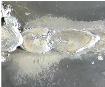
Sur GMAW Columna (Cráter y falta de fusión)
