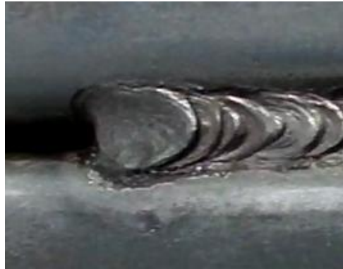
Centro SMAW Viga secundaria (cráter, falta de fusión)
