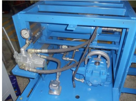
Figura 5.4 Vista de los tramos de tubería del equipo
