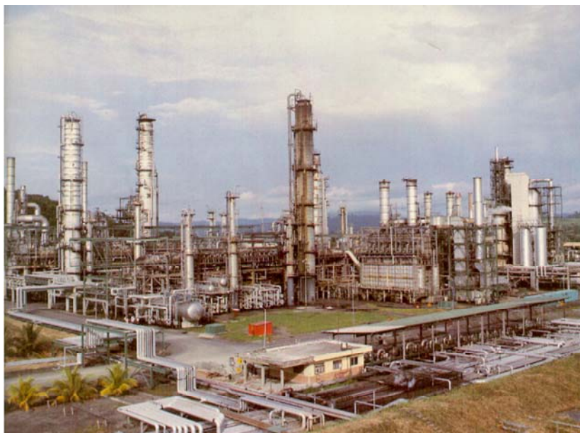
Figura 11. Fotografía Refinería Esmeraldas. (Gerencia de Refinación de EP Petroecuador, 2011)
