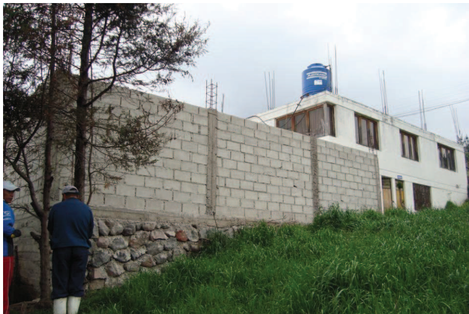
FOTO 8. Área de ubicación de la cisterna, diciembre 2012.
