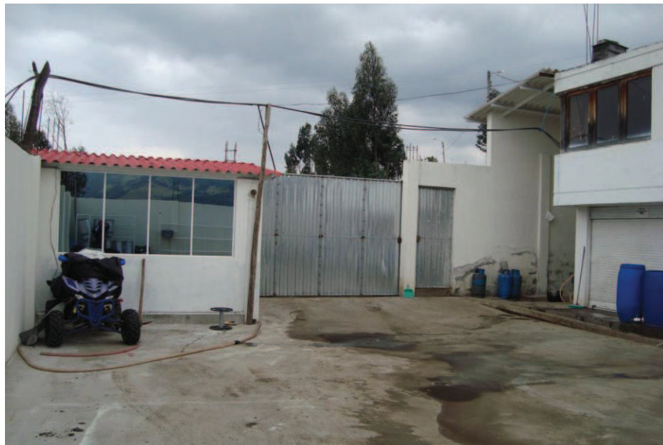
FOTO 10. Área de Carga y Descarga de la Planta, diciembre 2012.
