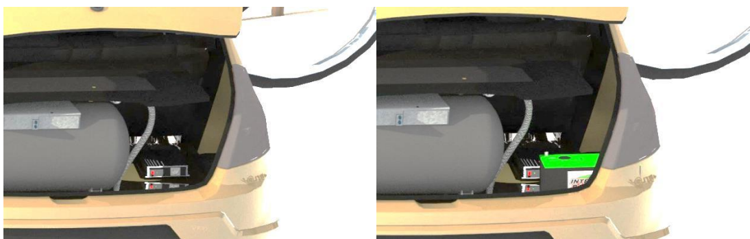
Figura No. 5.19: Instalación del inversor y batería auxiliar
