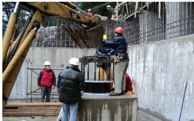
Figura 67 Montaje aisladores sísmicos (Mellado, 2012)
