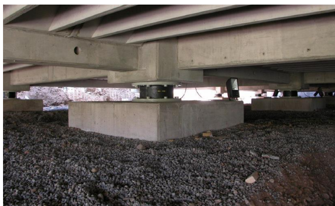
Figura 69 Sistema de aislación (Mellado, 2012)
