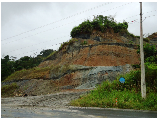
Fotografía N° 49: Extracción de materiales
