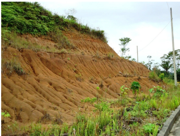
Fotografía N° 21: Erosión del suelo sector Santa Clara
