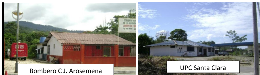
Fotografía N° 40-41: Infraestructura de seguridad
