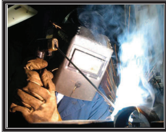
Figura 2.15 Soldadura por arco
