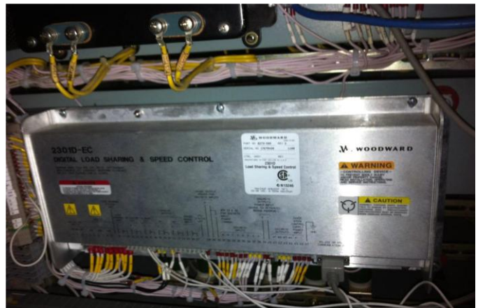
Figura 6.Regulador de Velocidad y Potencia, Woodward 2301D.
