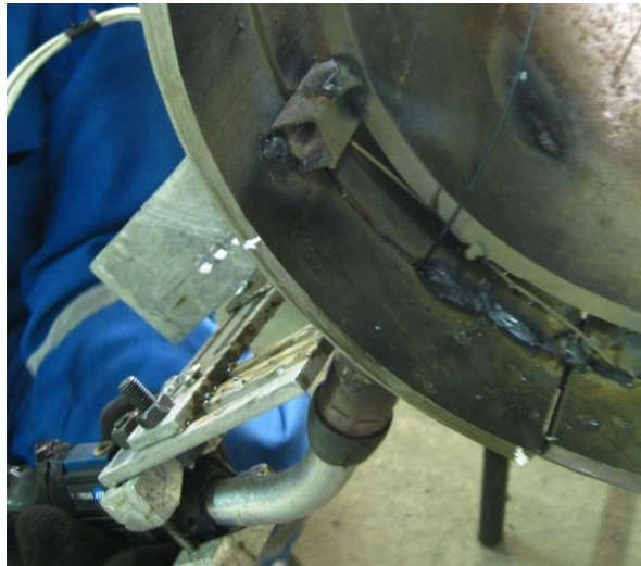
Figura 6.Excesivo Amperaje en el cordón de raíz
