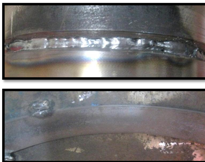
Figura 83. Junta soldada con respaldo izquierda-Prueba de Soldadura 2.b.
