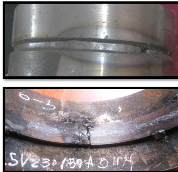
Figura 84. Junta soldada con respaldo izquierda-Prueba de Soldadura 3.
