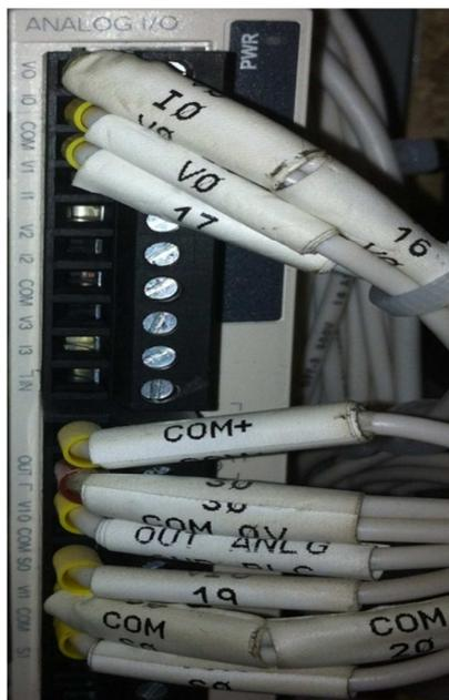
Fotografía 7. Módulo de ampliación de salidas y entradas analógicas instalado en el panel de control de la UG4, Twido
