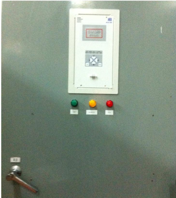
Fotografía 9. Dispositivo DECS - 200 instalado en la sala de máquinas de la C.T. Guangopolo
