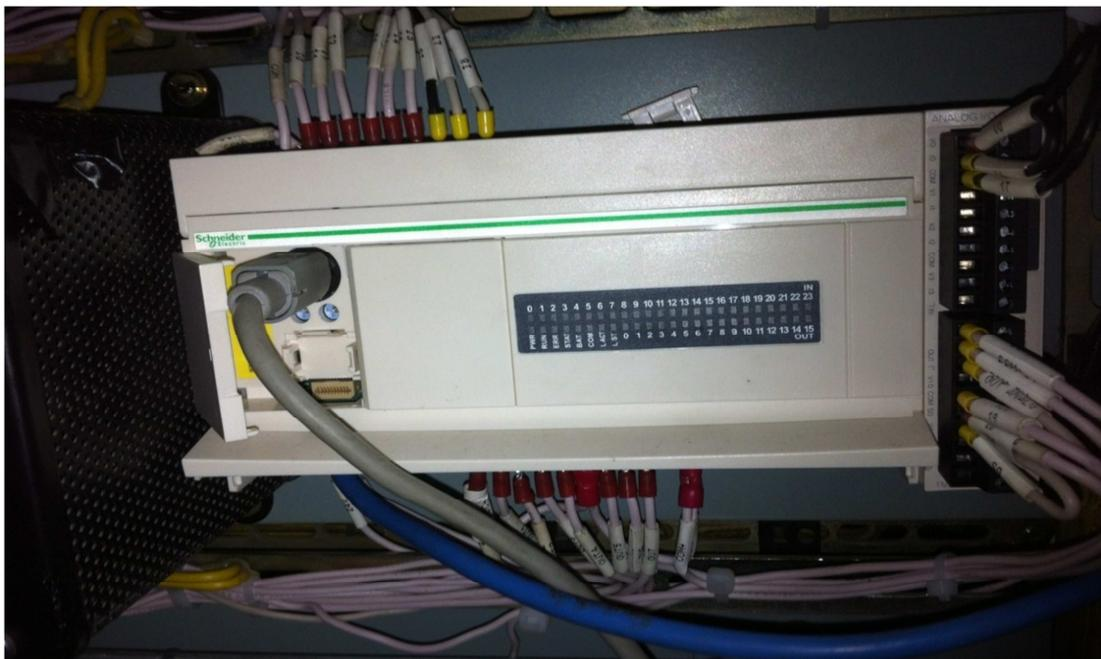
Fotografía 5. PLC instalado en el panel de control de la UG4, Twido
