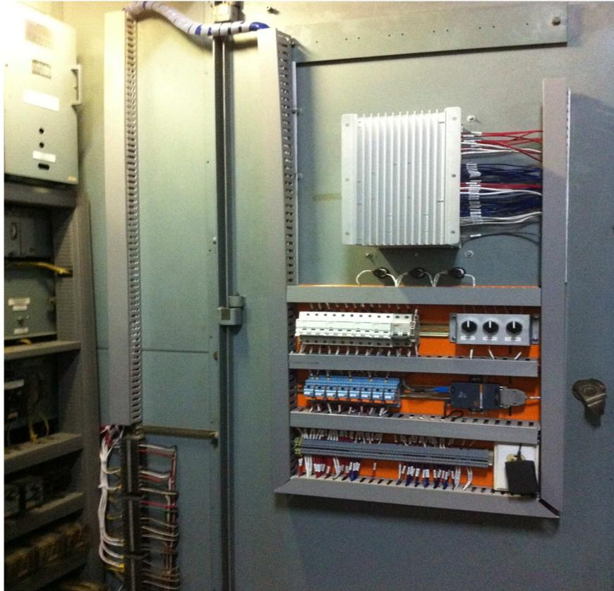
Fotografía 10. Sistema de Control de Voltaje instalado en la sala de máquinas de la C.T. Guangopolo
