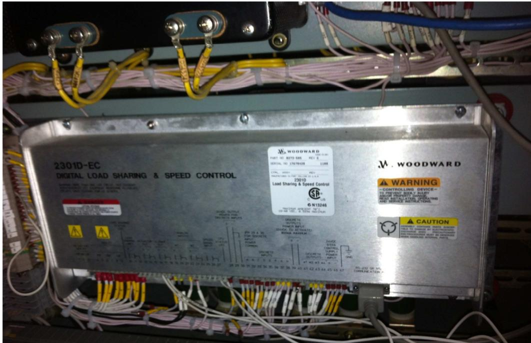
Fotografía 4. Regulador de Velocidad instalado, Woodward 2301D
