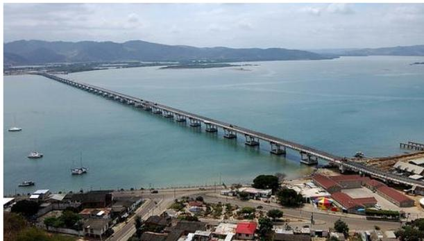
**Figura 13: Puente los Caras aislado sísmicamente con FPS (FRICTION PENDULUM SYSTEM)**
