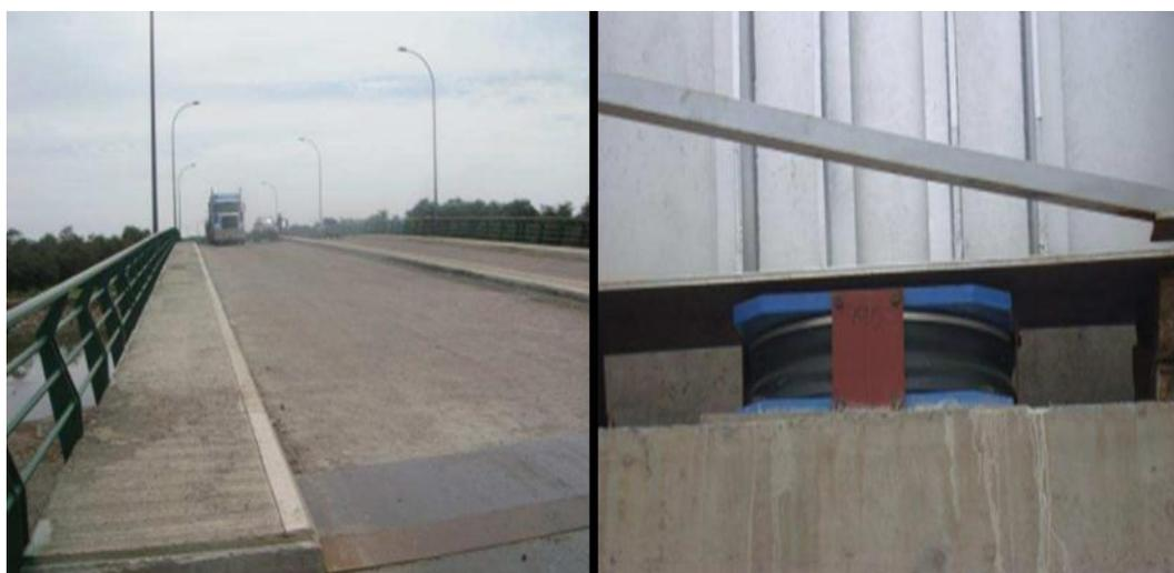
**Figura 14: Puente Norte (Esmeraldas) con Aisladores Elastoméricos FPS**
