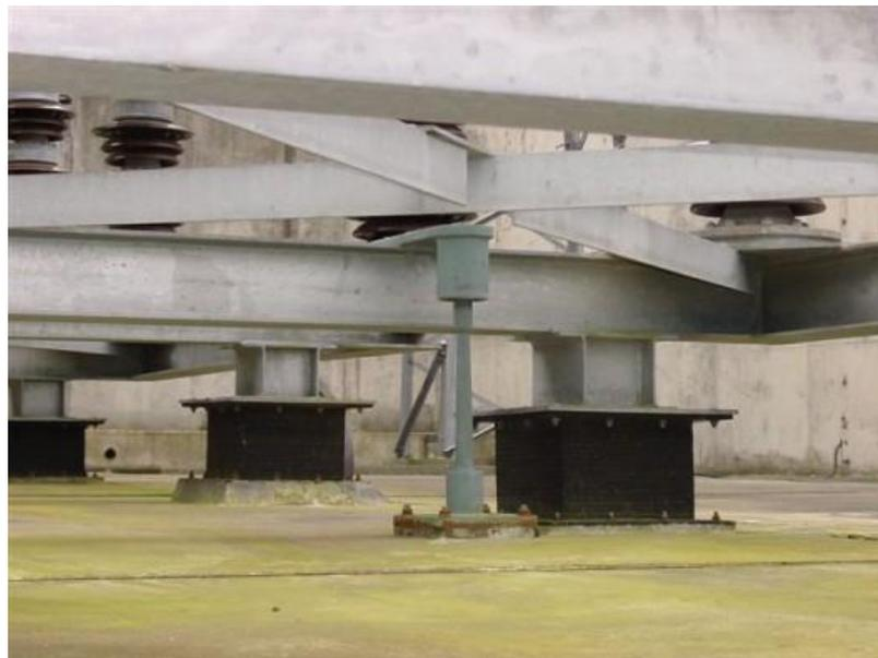
**Figura 5: Aisladores Sísmicos Elastoméricos en la base de una edificación.**
