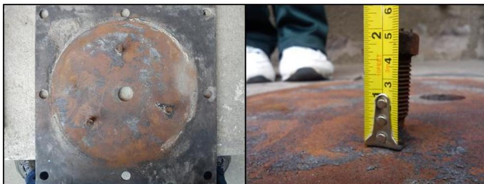
**Figura 104: Placa de Anclaje con pernos para mejorar la adherencia con el caucho.**
