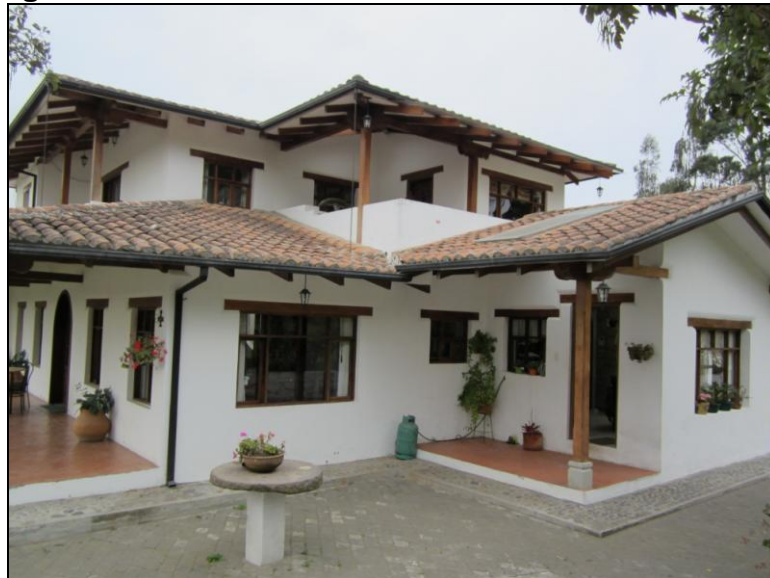
Figura N° 2.5 Parte adicional del lado Este de la casa
