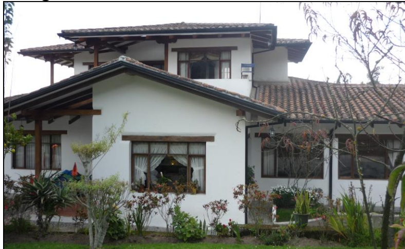
Figura N° 2.4 Fachada exterior Este de la casa
