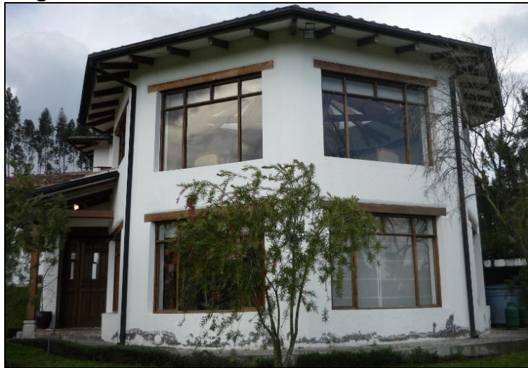
Figura N° 2.6 Fachada exterior Oeste de la casa
