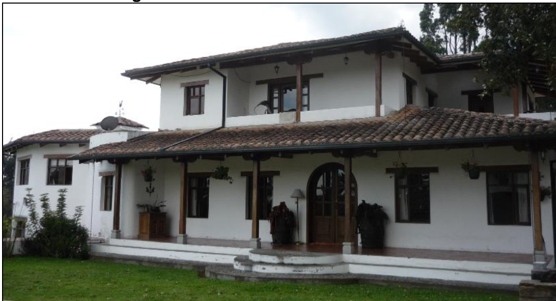
Figura 2.3 Fachada exterior Sur de la casa
