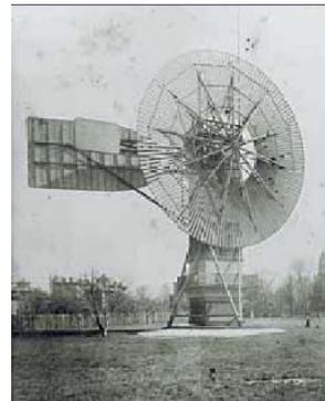
**Figura 1** Turbina eólica de Brush en Cleveland (12kW, 17 metros)
