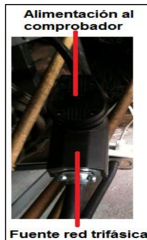
Figura 1: Conexión a la red trifásica.
