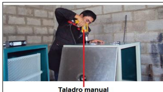
Figura 4. 7: Perforaciones en la estructura. Fuente: Grupo de investigación.
