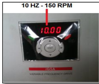
Figura 4. 67: Regular 150 RPM en el variador de 10 HP. Fuente: Grupo de investigación.
