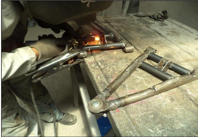
**Figura 10.1: Soldadura base de los amortiguadores.**
