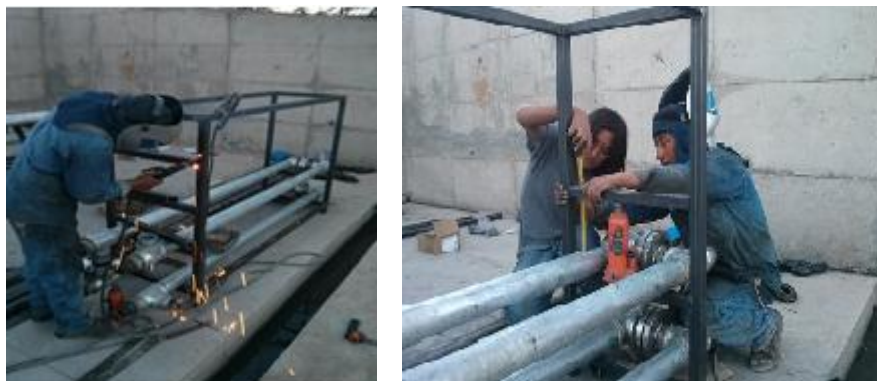
Figura 105 Construcción estructura soporte
