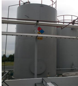
Figura 3 Tanque de almacenamiento de agua
