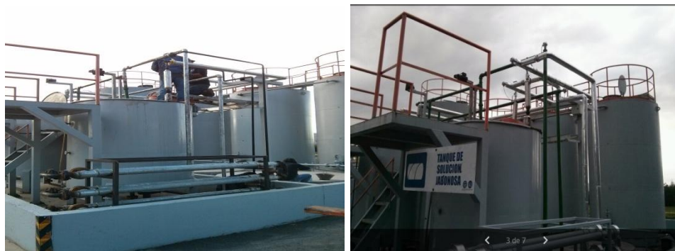
Figura 108 Construcción de líneas de alimentación
