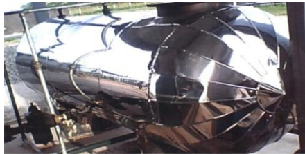
Figura 74 Revestimiento mecánico para un tanque
