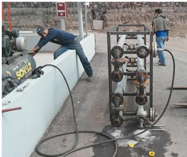
Figura 112 Proceso de prueba neumática
