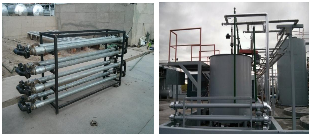
Figura 107 Intercambiador de calor en construcción
