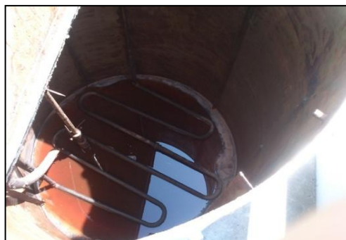
Figura 5 Intercambiador de calor de tipo serpentín y hélice
