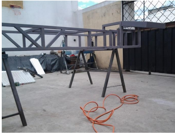
Fuente: Grupo de Investigación Figura 4.20: Después de haber aplicado la pintura anticorrosiva
