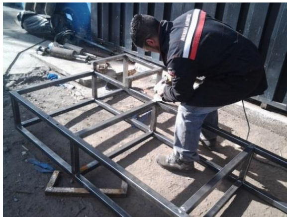
Figura 4.17: Estructura lista para masillar
