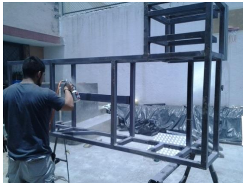
Fuente: Grupo de Investigación Figura 4.19: Aplicando pintura anticorrosiva
