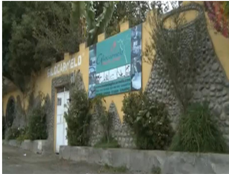
Fotografía N°37 Facha principal de la hostería Gilocarmelo, 2013.
