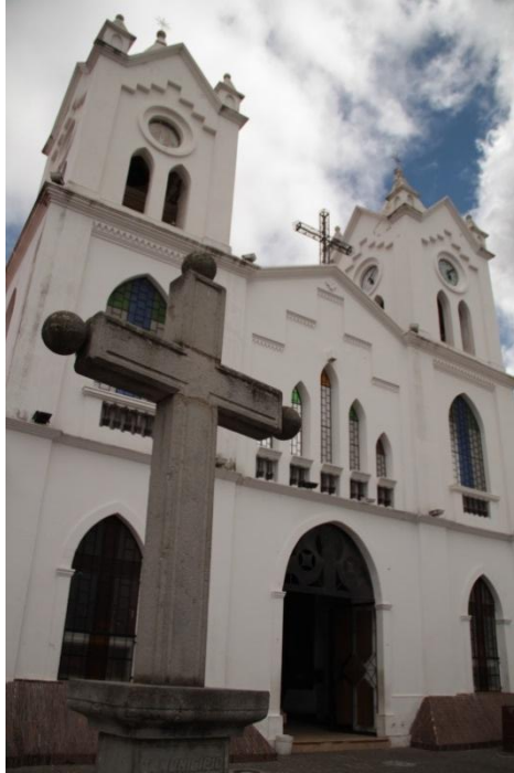
Fotografía N°29 Iglesia Matriz vista frontal a la fachada principal, 2013.
