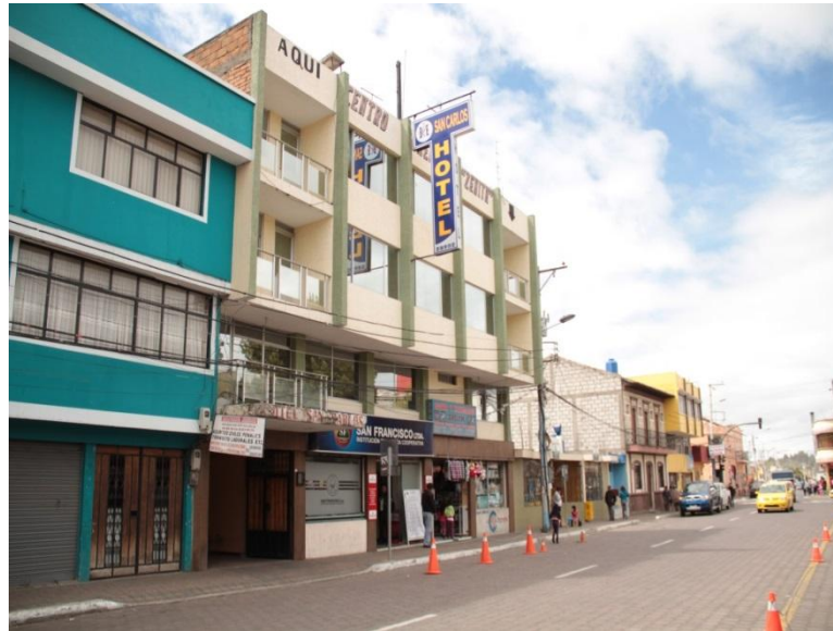
Fotografía N°41 Fachada del hotel San Carlos, vista desde el parque central La Concordia, 2013.
