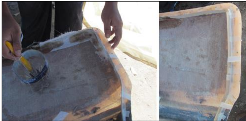
Figura 5.29: Construcción de la ceja en la puerta
