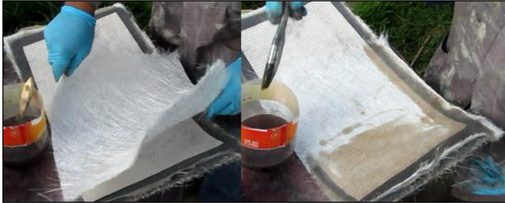
Figura 5.8: Segunda capa de fibra de vidrio.
