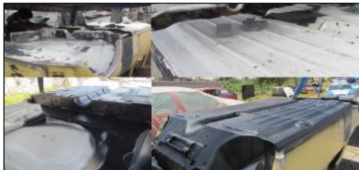
Figura 5.26: Limpieza y recubrimiento de la MINIVAN.
