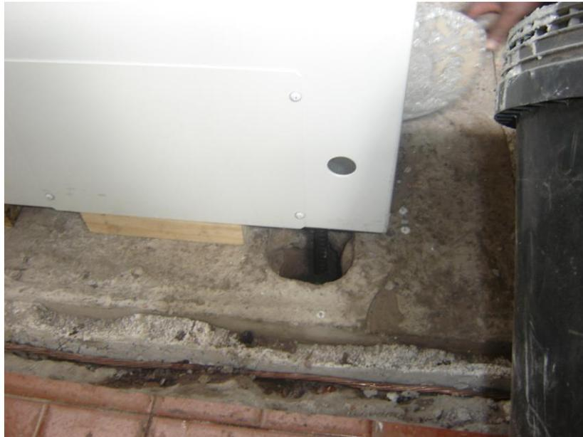
**Figura 2.8 Cimentación de la unidad de control**
