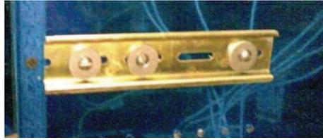
Foto. 3.59 Colocación de la riel dim
