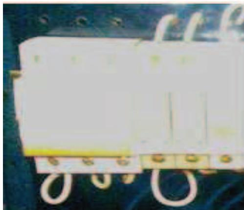
Foto 3.64 Conexiones de portafusibles y disyuntor
