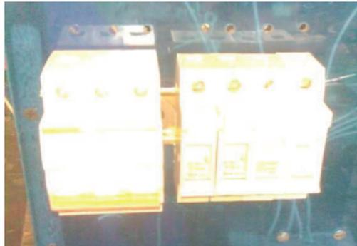
Foto 3.60 Ubicación del disyuntor y portafusibles en la riel dim
