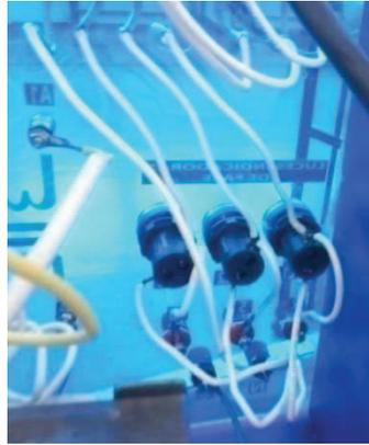
Foto 3.65 Conexiones de portafusible y luces piloto
