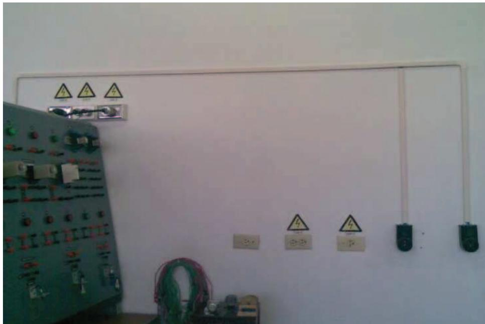
Foto 3.7 Adecuación de alimentación trifásica terminada
