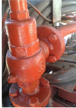
Figura 2.12 Válvula de retorno reguladora de presión Fuente: (Autor, 2014)
