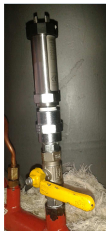
Figura 6.40 Mantenimiento transductor presión Fuente: (Autor, 2014)
