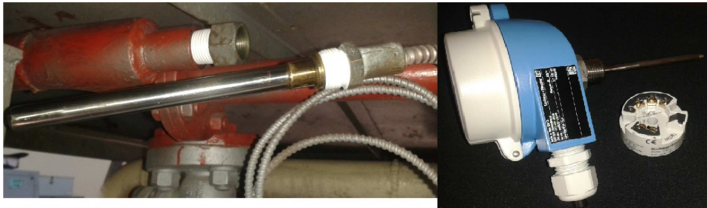
Figura 6.3 Antiguo termómetro y nueva RTD Fuente: (Autor, 2014)
