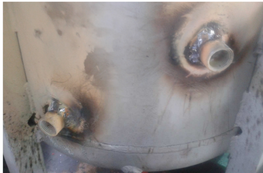
Figura 4.13 Soldadura de acoples en tanque principal Fuente: (Autor, 2014)
