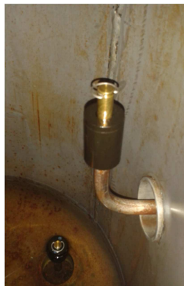
Figura 6.38 Mantenimiento de flotadores antiguos Fuente: (Autor, 2014)
