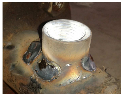
Figura 4.11 Soldadura de acople en la tubería de salida Fuente: (Autor, 2014)
