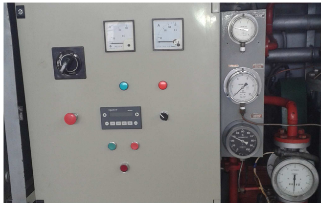
Figura 4.5 Montaje de manómetros en tablero Fuente: (Autor, 2014)
