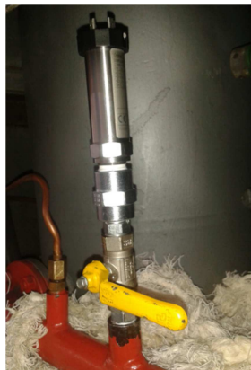
Figura 4.7 Montaje del transductor de presión Fuente: (Autor, 2014)
