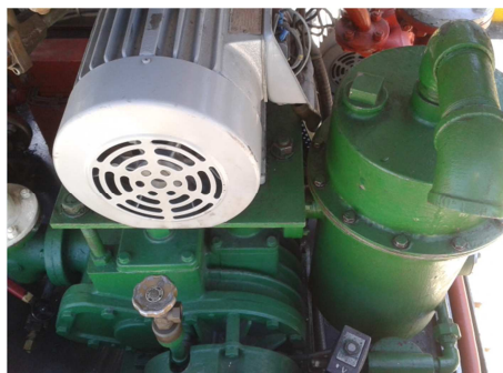
Figura 6.35 Mantenimiento de tanque y aceite de vacío
