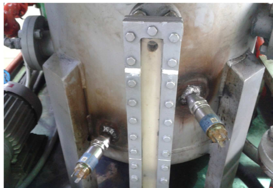
Figura 4.14 Montaje de detectores de nivel en tanque principal Fuente: (Autor, 2014)
