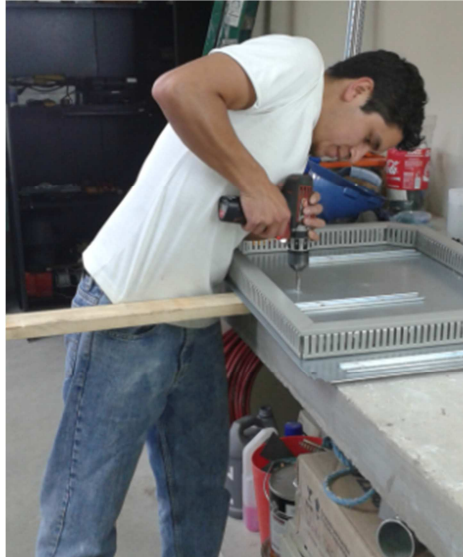
Figura 4.18 Taladrado de placa de montaje del tablero Fuente: (Autor, 2014)
