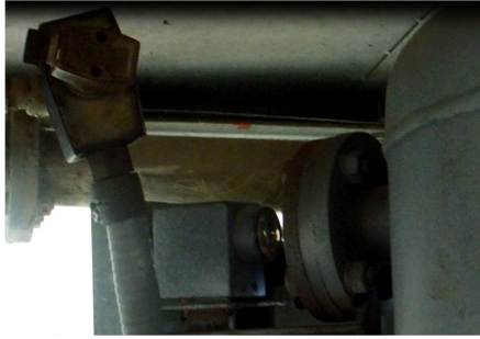
Figura 6.8 Receptor sensor óptico y electroválvula LV Fuente: (Autor, 2014)
