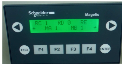
Figura 5.14 Estado de los actuadores en el funcionamiento Fuente: (Autor, 2014)
