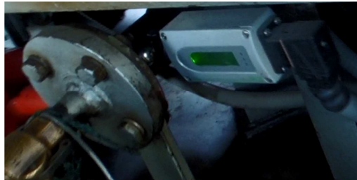
Figura 4.12 Montaje transmisor de humedad Fuente: (E+E ELEKTRONIK, 2013)
