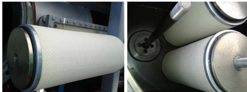
Figura 6.33 Mantenimiento de filtros en el tanque principal Fuente: (Autor, 2014)
