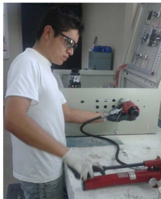
Figura 4.21 Prensado de orificios para terminales de manguera BX Fuente: (Autor, 2014)
