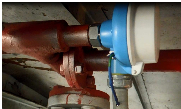
Figura 4.16 Montaje RTD en tubería Fuente: (Autor, 2014)
