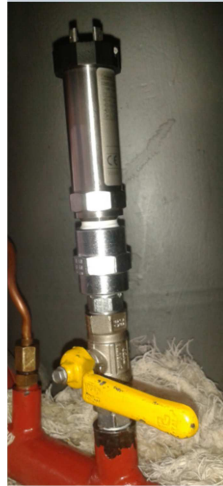
Figura 6.5 Transductor de presión y válvula de corte Fuente: (Autor, 2014)
