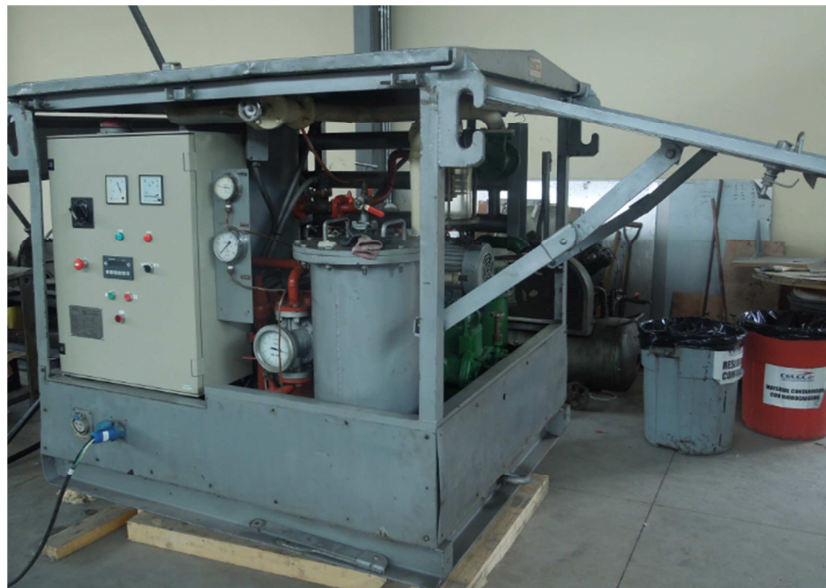
Figura 4.25 Purificadora luego de trabajos de construcción y montaje Fuente: (Autor, 2014)
