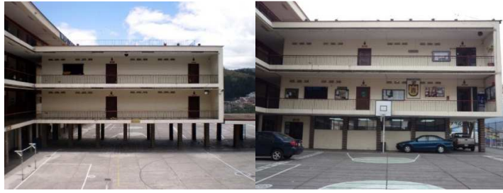
Fig. 5: Bloques 2 y 3 de la Escuela Sucre
