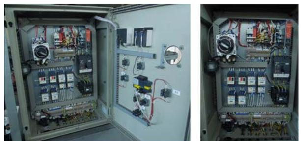
Figura 3.6 Tablero de control posterior a los trabajos realizados
