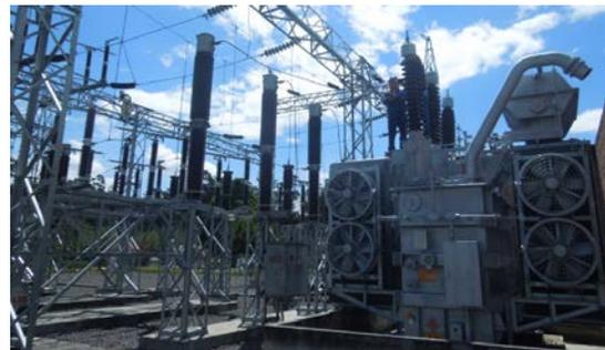
Figura 1.1 Transformador de 20 MVA en la subestación de Termopichincha
