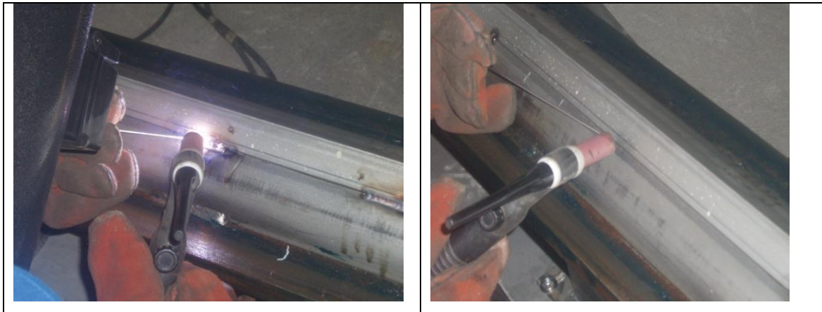
Figura 6.6 Suelda de Acero Inoxidable
