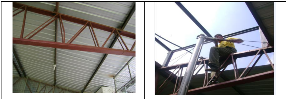
Figura 6.31 Adecuación en tumbado
