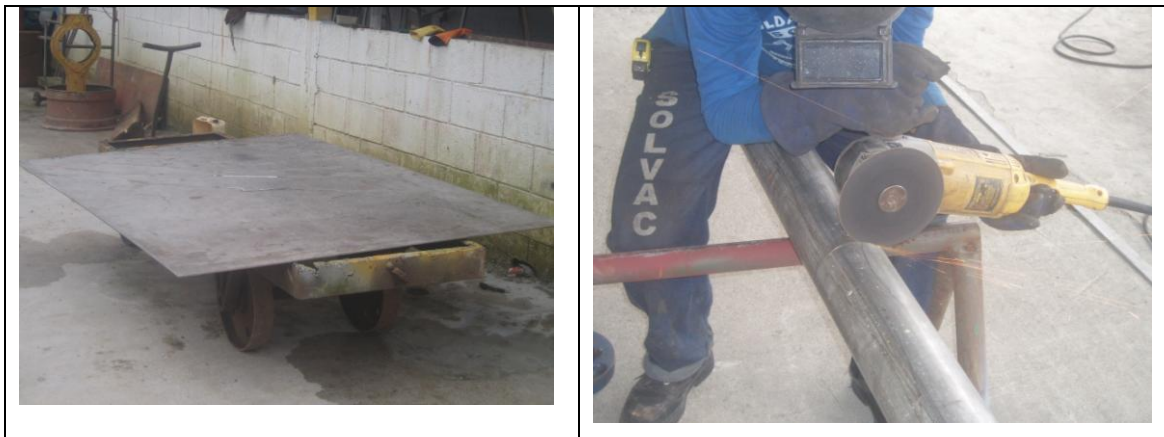
Figura 6.2 Adecuación de Materiales
