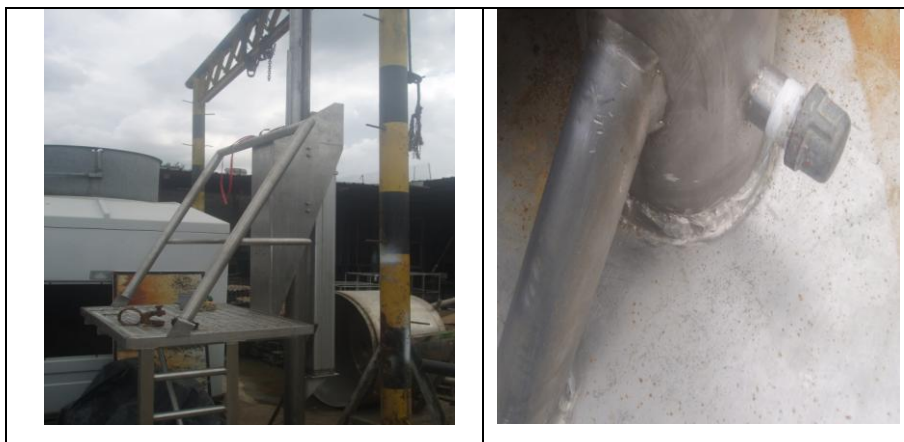
Figura 6.21 Montaje de la Estructura
