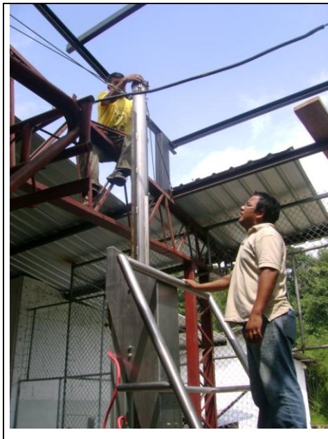
Figura 6.33 Adecuación de templadores
