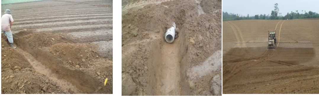
Elaboración de camas para la siembra y zanjas para drenaje
