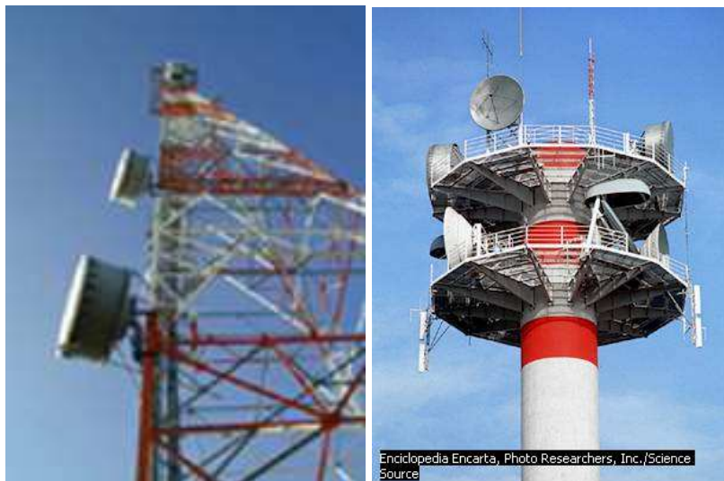
Fig.C-2 Antenas de microonda
