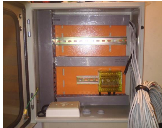
Figura 12. Etapa final del cableado.
