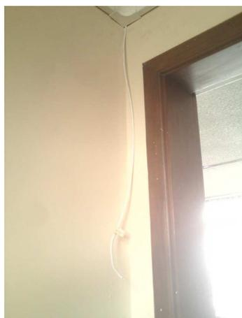
a) Cableado y canaleta para sensor de movimiento.
