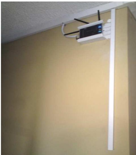
Figura 61. Cableado y canaleta para estación manual.
