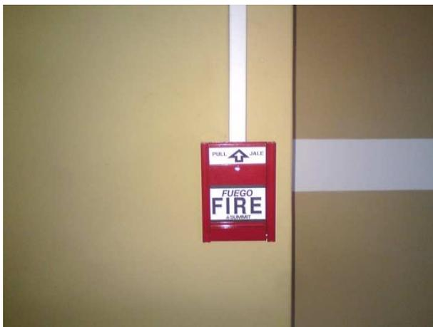
Figura 78. Estación Manual en “Planta Baja”.
