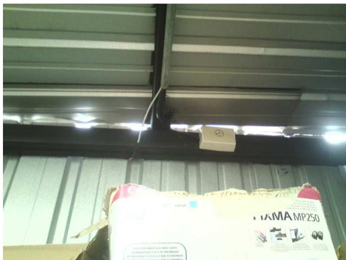
c) Cableado y tomacorriente para la cámara análoga.
