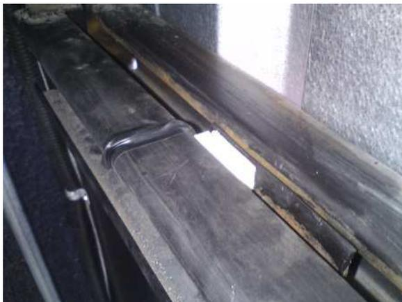
Figura 68. Contacto magnético ubicado en la puerta de la bodega.
