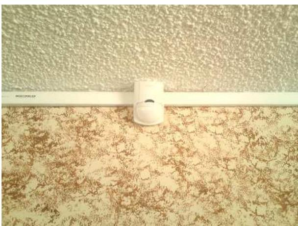
Figura 74. Sensor de Movimiento ubicado en el ingreso de la planta.
