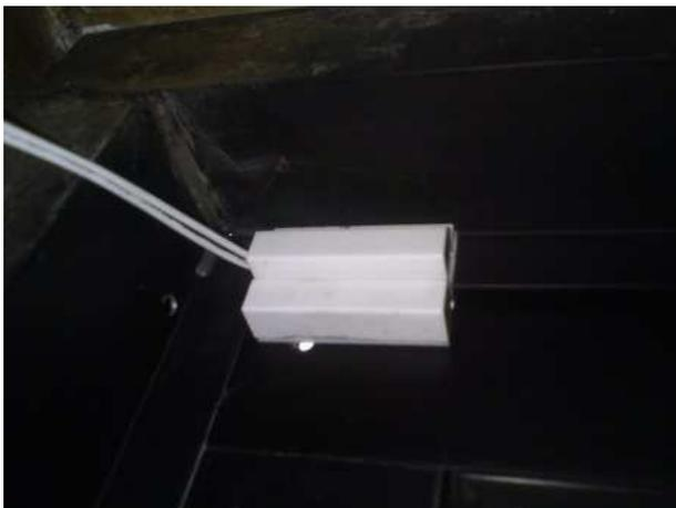
Figura 75. Contacto magnético ubicado en la puerta a "Terraza 1".
