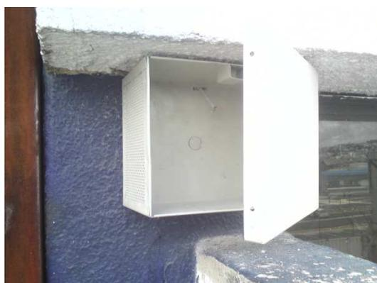
c) Cableado y cajetín para la instalación de la sirena externa.
