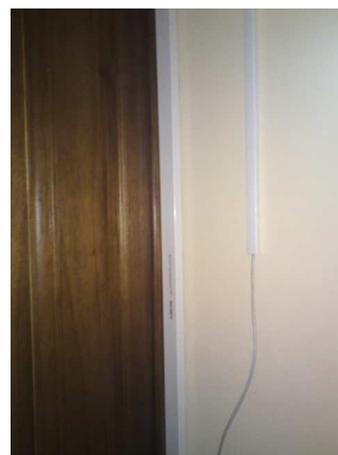
b) Cableado y canaleta para el teclado INS-050.
