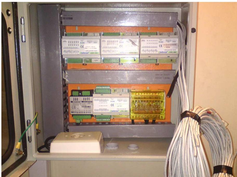
Figura 84. Cableado desde los dispositivos periféricos al gabinete.
