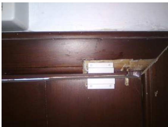
Figura 69. Contacto magnético ubicado en la puerta de ingreso.
