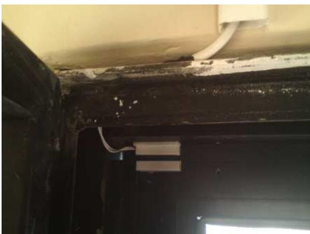
Figura 76. Contacto magnético ubicado en la puerta a "Terraza 2".
