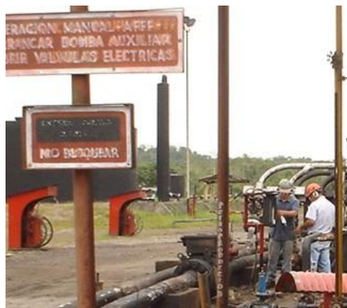
Foto No. 17. Extintores de Polvo Químico ubicados en campo de producción
