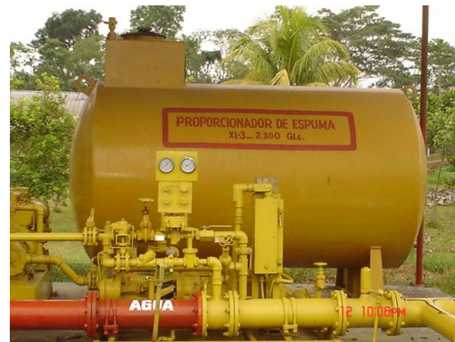
Foto No. 43. Red de agua (rojo), Red de espuma (amarillo)
