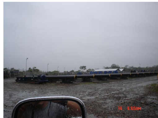
Foto No. 57. Tubería acondicionada para reutilizar
