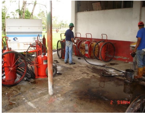
Foto No. 50. Extintores de Polvo Químico en actividades de limpieza y recarga luego de su utilización en una contingencia
