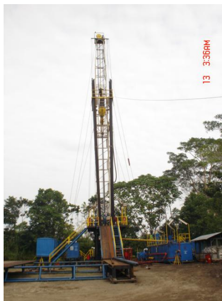
Foto No. 29. Torre de reacondicionamiento para pozos
