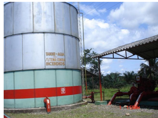
Foto No. 37. Tanque Reservoirio
