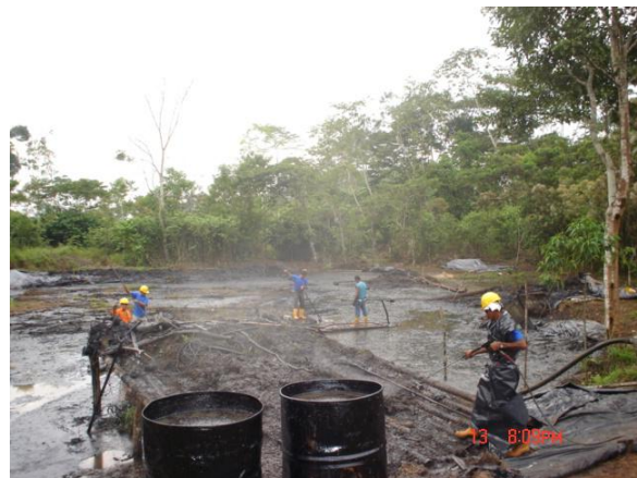
Foto No. 15. Limpieza de sólidos en parrilla (Piscina del Pozo 78)
