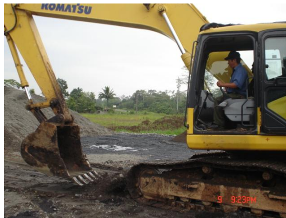
Foto No. 23. Remoción de suelo contaminado con crudo
