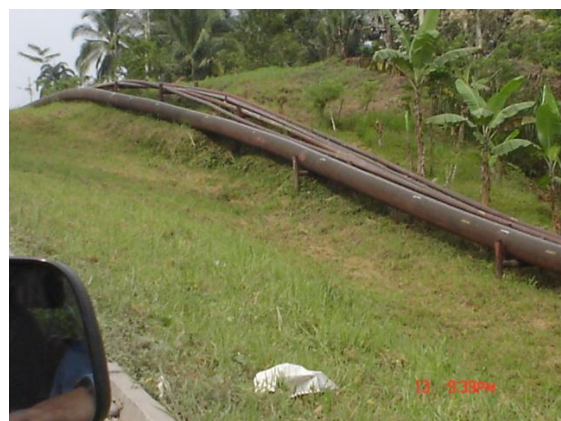
Foto No. 28. Desbroce de Líneas de Flujo
