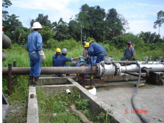
Foto No. 20. Inspección y Mantenimiento de válvulas
