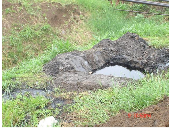
Foto No. 22. Fosas de contención de derrames
