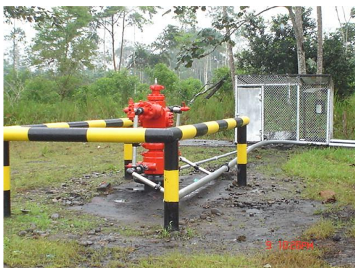
Foto No.8. Bombeo Hidráulico
