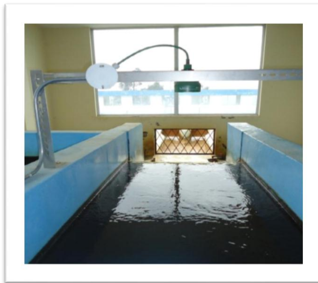
Figura Nº 1.4: Determinación de los Niveles de Agua
