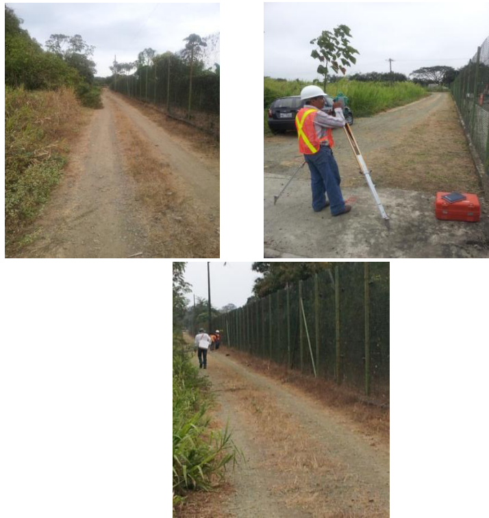
Figura :3 Vía existente en el límite de la Base Aérea de Taura. Elaboradopor :Capt Javier Urbina LL
