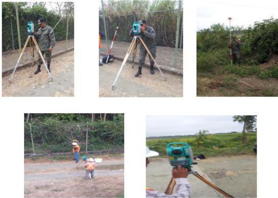
Figura :5 Detalle Fotográfico de la ejecución del Levantamiento Topográfico. Elaborado por: Capt Javier Urbina LL
