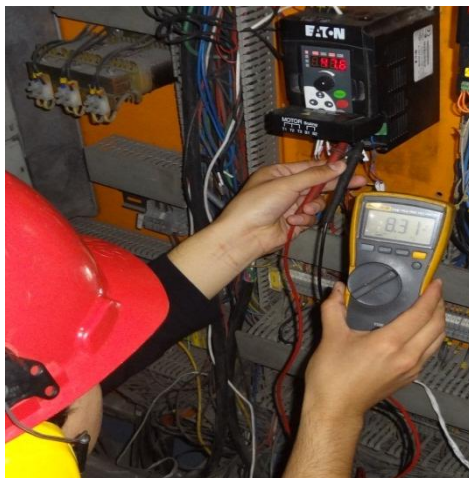
Figura 4. 9: Medición del voltaje en la entrada del variador
