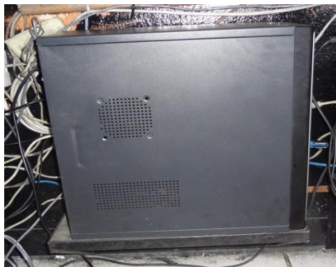
Figura 3. 30: Instalación de la PC y UPS.
