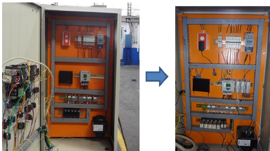
Figura 3. 16: Instalación de circuito de control en el tablero.
