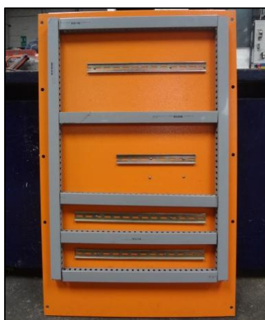
Figura 3. 13: Instalación de riel din y canaleta.
