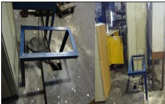
Figura 3. 4: Base anclada al suelo.
