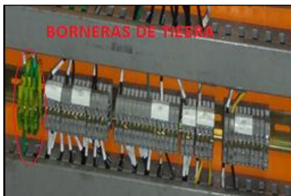
Figura 3. 15: Borneras de tierra.
