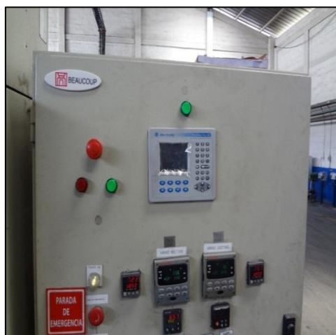
Figura 3. 19: Instalación de indicadores para el control de velocidad.
