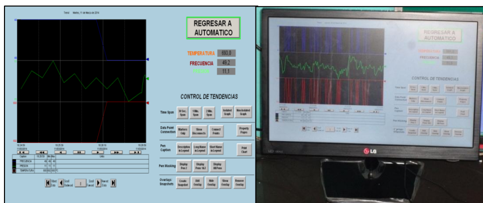
Figura 3. 68: Tendencias del SCADA
