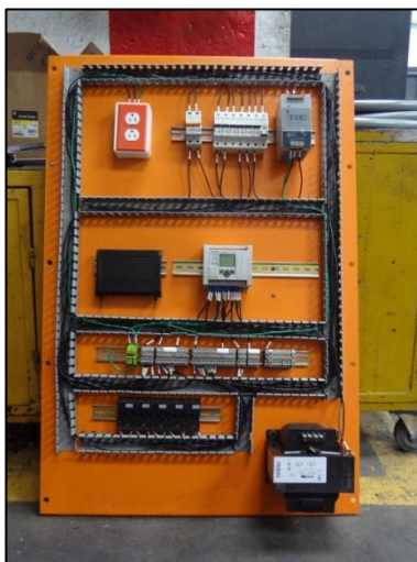
Figura 3. 14: Instalación de los equipos de control.
