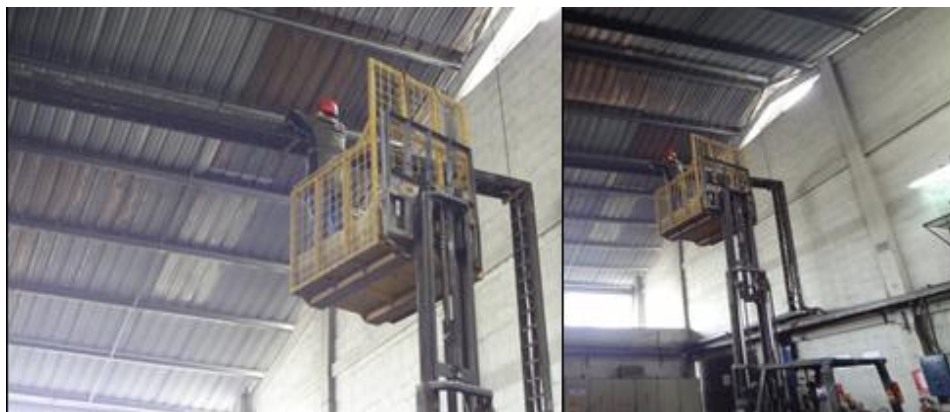
Figura 3. 9: Cableado de potencia y control
