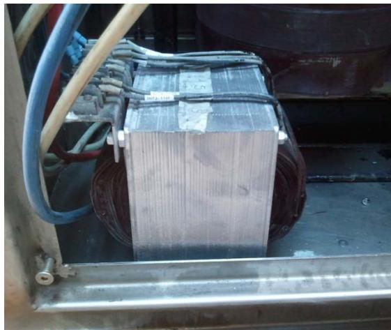
Figura. 68. Transformador de Aislamiento colocado en la base del tablero
