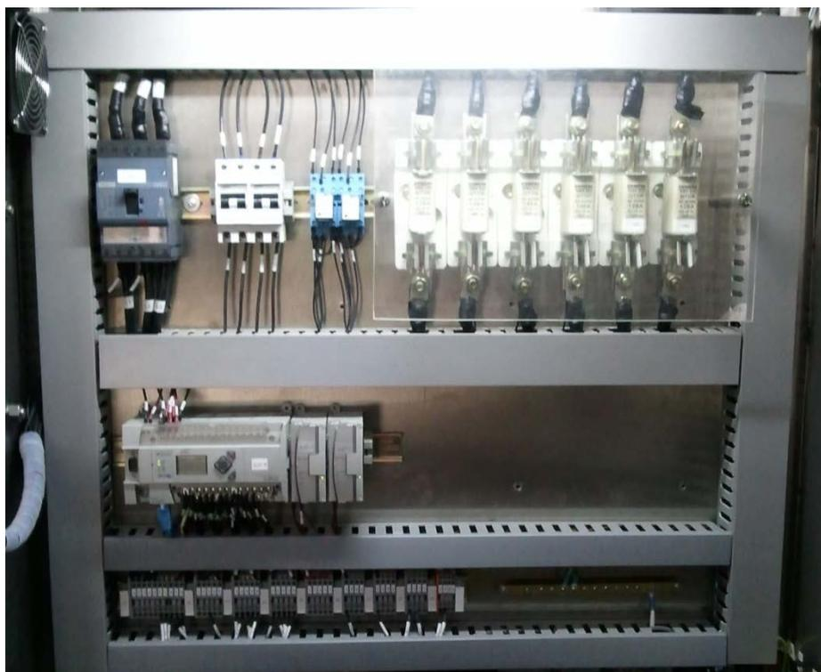
Figura. 80. Tablero delantero terminado.
