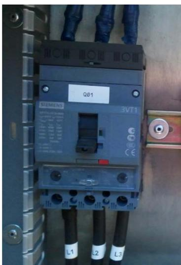
Figura. 64. Breaker de Caja moldeada colocado en Tablero
