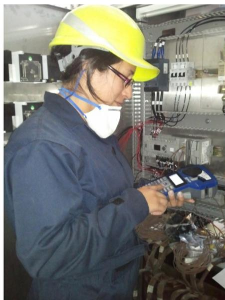
Figura. 78. Etiquetado de cableado del guarda fondo delantero.
