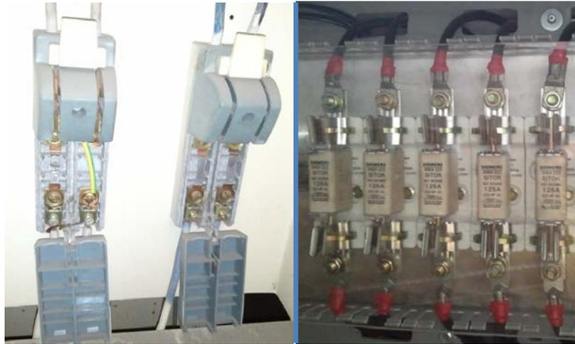
Figura. 4. Interruptores de cuchilla sustituidos por fusibles ultra-rápidos.
