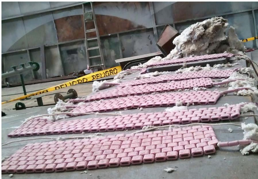
Figura. 103. Manta térmica, para cubrir a las resistencias.
