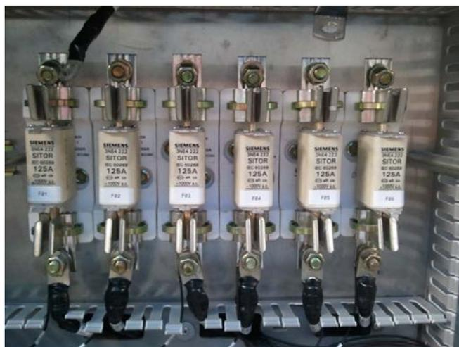
Figura. 62. Fusibles Ultra rápidos con base colocados en tablero.
