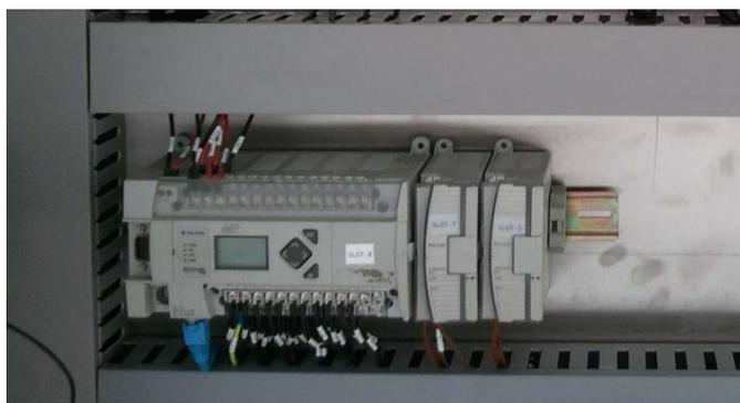
Figura. 69. PLC colocado en el tablero
