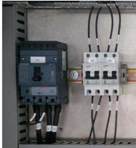
Figura. 66. Disyuntores conectados en Guarda Fondo de Tablero
