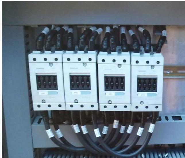
Figura. 58. Contactores colocados y etiquetados
