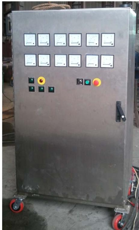
Figura. 57. Puerta del Tablero con dispositivos de medida.
