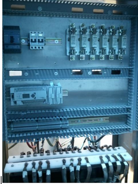
Figura. 73. Instalación de dispositivos en guarda fondo delantero.
