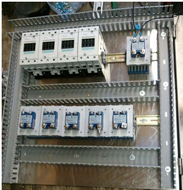
Figura. 74. Instalación de dispositivos en guarda fondo posterior.
