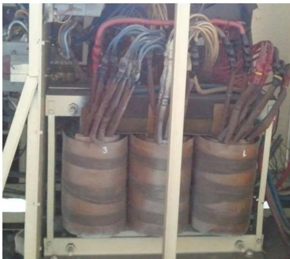
Figura. 47. Transformador de 80KVA a utilizar.
