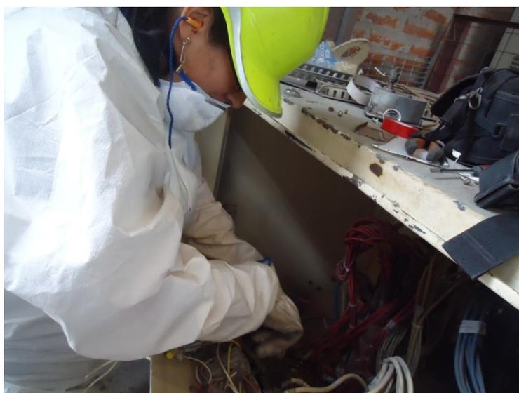
Figura. 48. Etiquetado de las terminales del Transformador.
