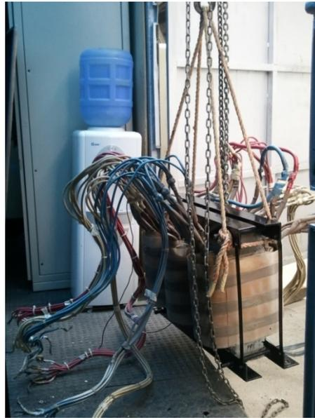
Figura. 50. Diagnóstico y limpieza del transformador.
