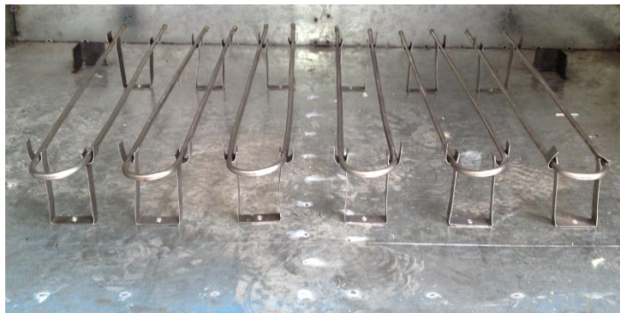
Instalación de las resistencias eléctricas.
