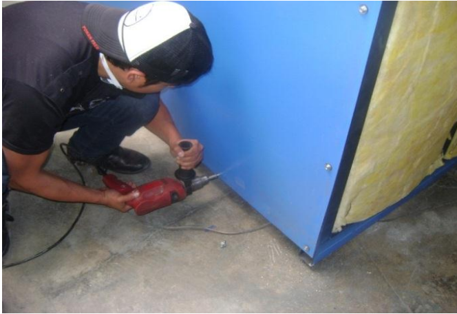
Ensamble mediante tornillo hexagonal autoperforante.
