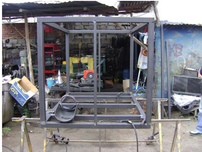
Figura 3. 2: Aspecto de la estructura metálica. (Aguirre/Sánchez, Fotografías del horno Electrico 2013)
