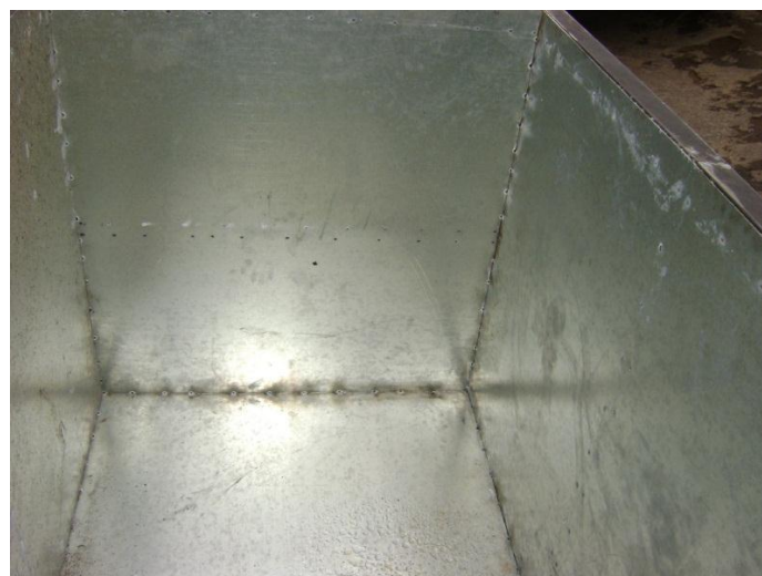
Figura 3. 3: Paredes interiores del horno. (Aguirre/Sánchez, Fotografías del horno Electrico 2013)
