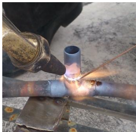
Figura 105 Colocación de acoples tipo “T”
