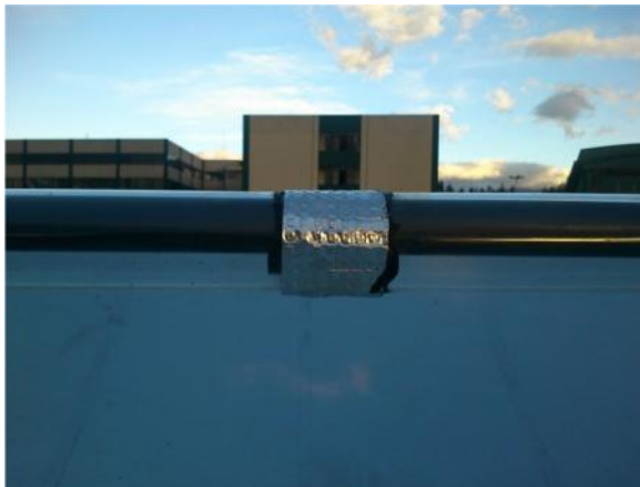
Figura 100 Unión de los tubos de vidrio
