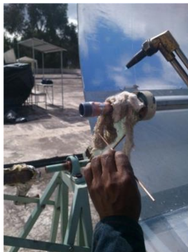
Figura 103 Soldadura de la tubería
