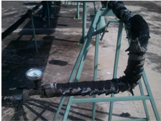
Figura 90 Aislante deteriorado
