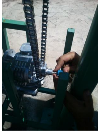
Figura 112 Instalación del potenciómetro
