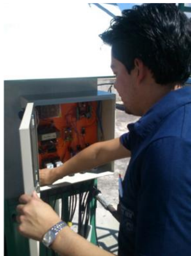
Figura 109 Instalación de caja de control
