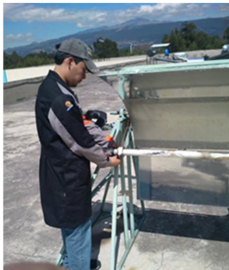
Figura 98 Desmontaje de la tubería de cobre
