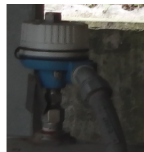
Figura 10. RTD PT100 con termopozo.
