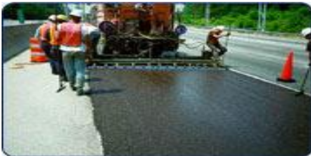
Figura 2.10: Colocación de un Micropavimento en la vía
