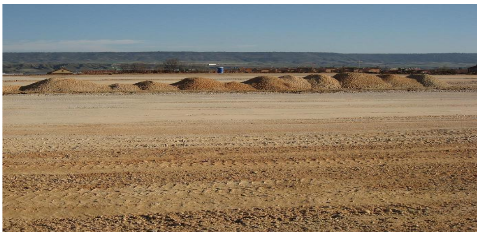
Figura 2.1: Suelo en terraplenes
