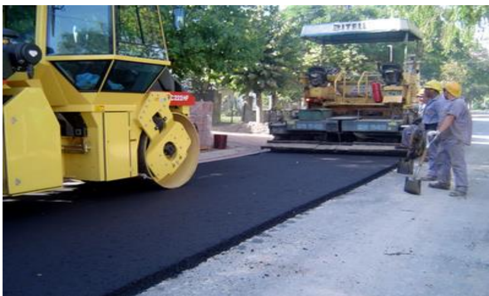
Figura 2.7: Colocación de asfalto en vías
