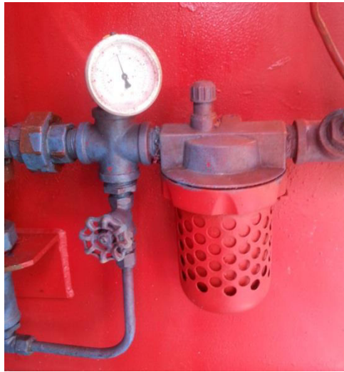
Figura 2.22. Filtro en línea de suministro de aire, CPV-23.
