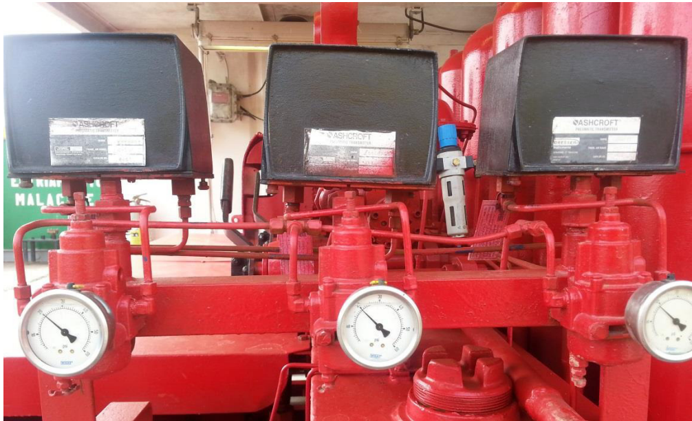
Figura 2.38. Transmisores neumáticos de presión, CPV-23.
