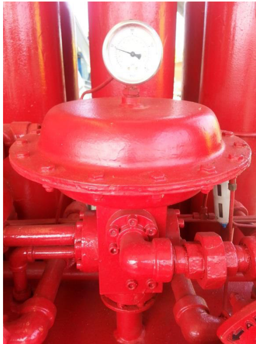
Figura 2.33. Válvula neumática reguladora del preventor anular, CPV-23.
