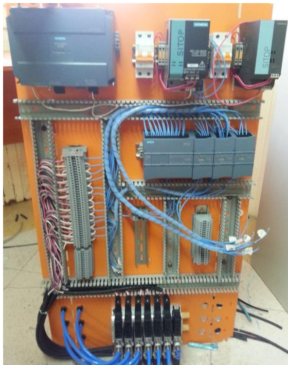
Figura 4.21. Montaje de equipos y conexiones eléctricas.
