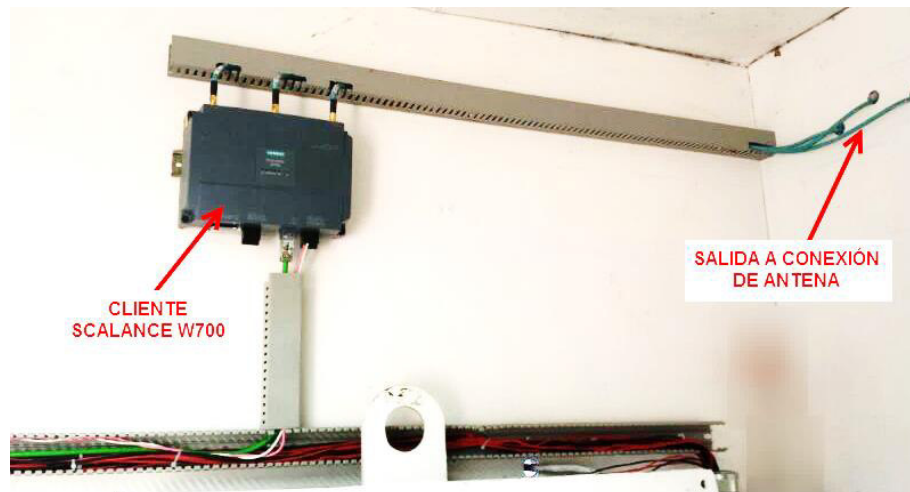
Figura 4.38. Instalación del sistema de comunicación de la Casa del Perro.
