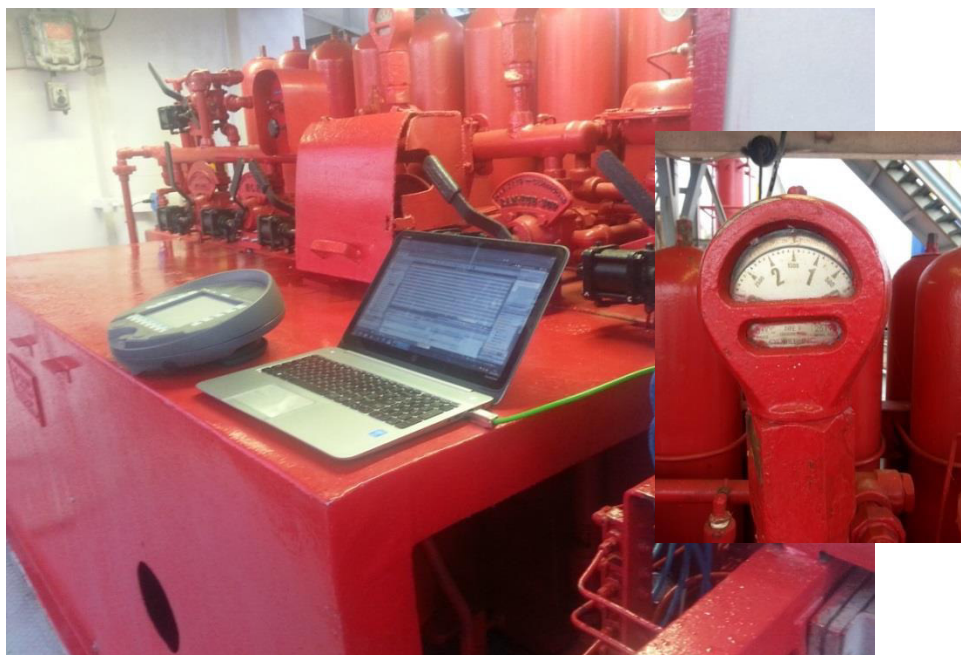
Figura 4.68. Calibración de sensores en sitio desde computadora.
