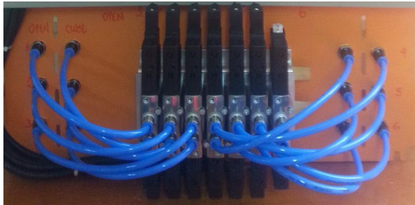
Figura 4.14. Armado de mangueras a través de los pasamuros.
