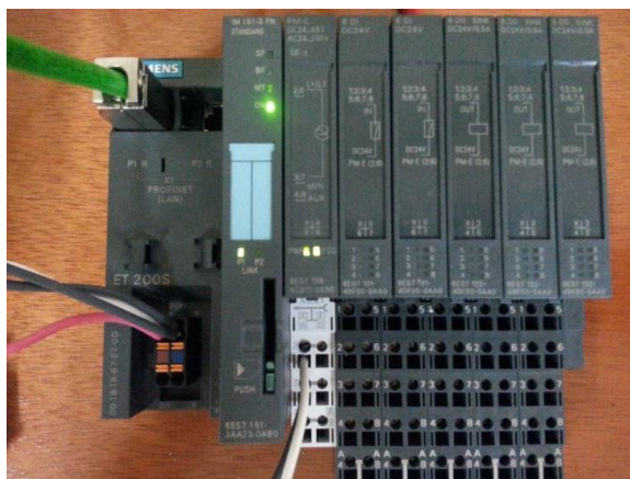
Figura 4.50. Instalación de módulos en el dispositivo periférico ET200S
