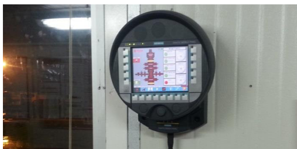
Figura 4.51. Montaje de estación de carga en oficina de Operaciones
