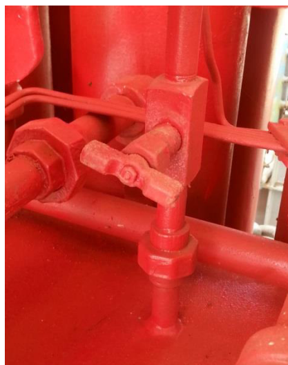
Figura 2.36. Válvula de purga, CPV-23.
