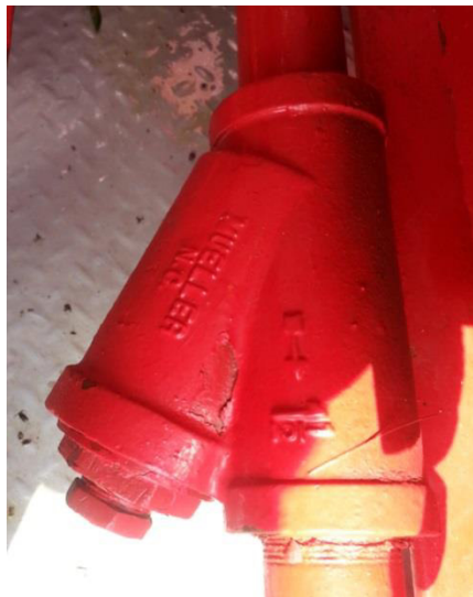
Figura 2.27. Filtro de succión hacia la bomba triple, CPV-23.
