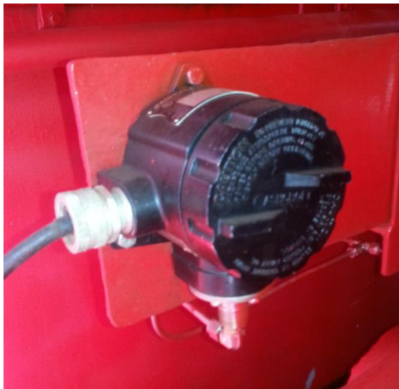
Figura 2.28. Interruptor de presión eléctrico, CPV-23.
