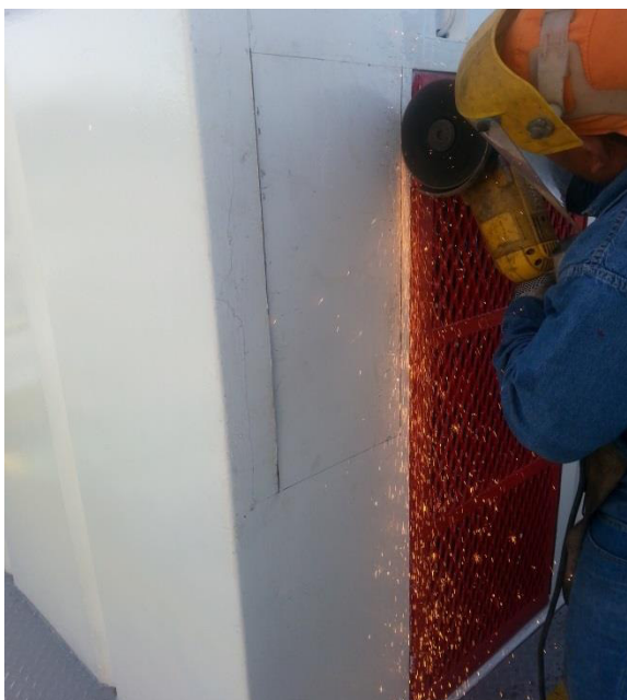
Figura 4.42. Corte en pared frontal de la Casa del Perro
