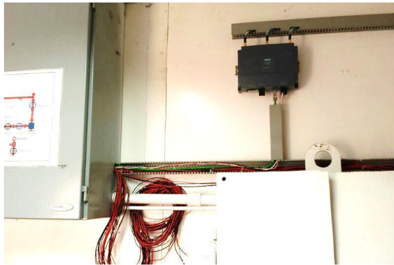
Figura 4.49. Tendido eléctrico para el panel eléctrico remoto.
