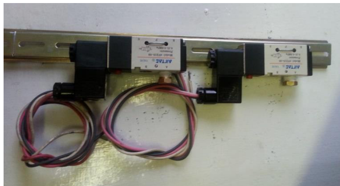
Figura 4.47. Montaje de electroválvulas del sistema de alarma general.
