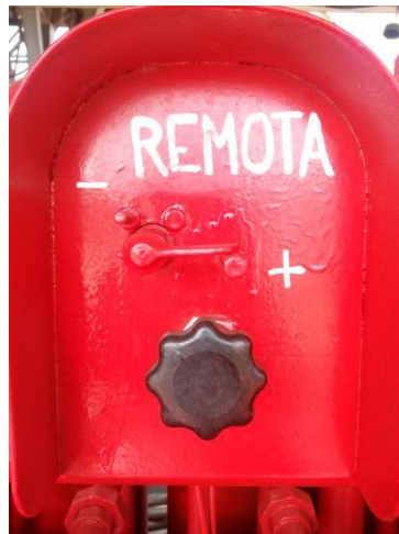
Figura 2.39. Selector de unidad de panel, CPV-23.
