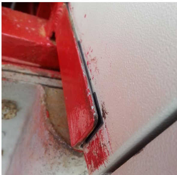
Figura 4.4. Aisladores de vibración en gabinete del acumulador de presión.
