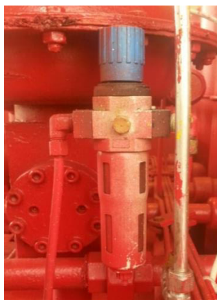
Figura 4.17. Unidad FRL para la válvula proporcional.
