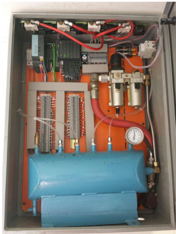
Figura 4.37. Cajera de la Casa del Perro
