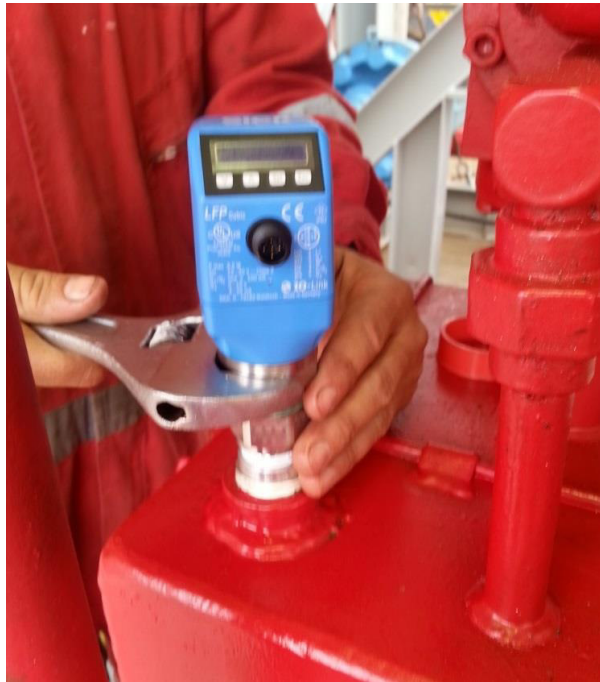
Figura 4.29. Instalación final del sensor de nivel TDR en el reservorio.
