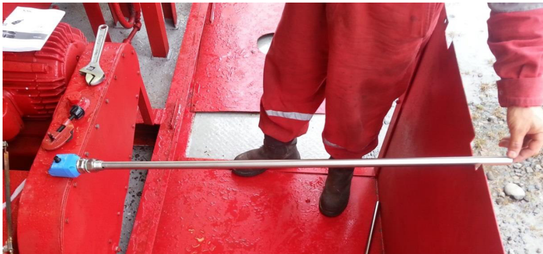
Figura 4.27. Instalación de tubo coaxial de sensor TDR.
