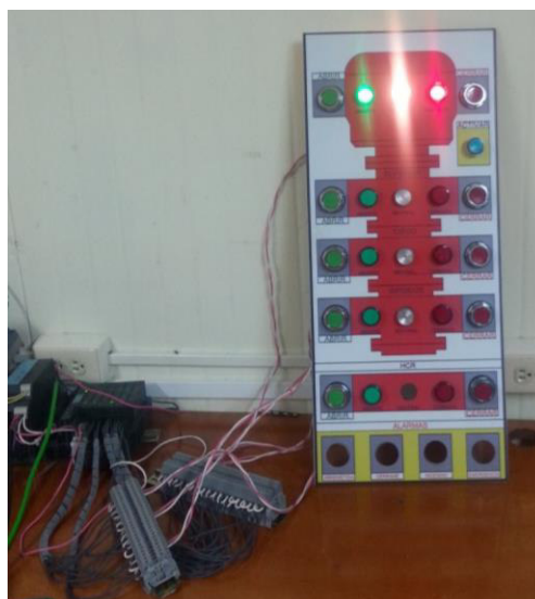
Figura 4.55. Prueba de luces piloto y pulsadores del panel eléctrico.
