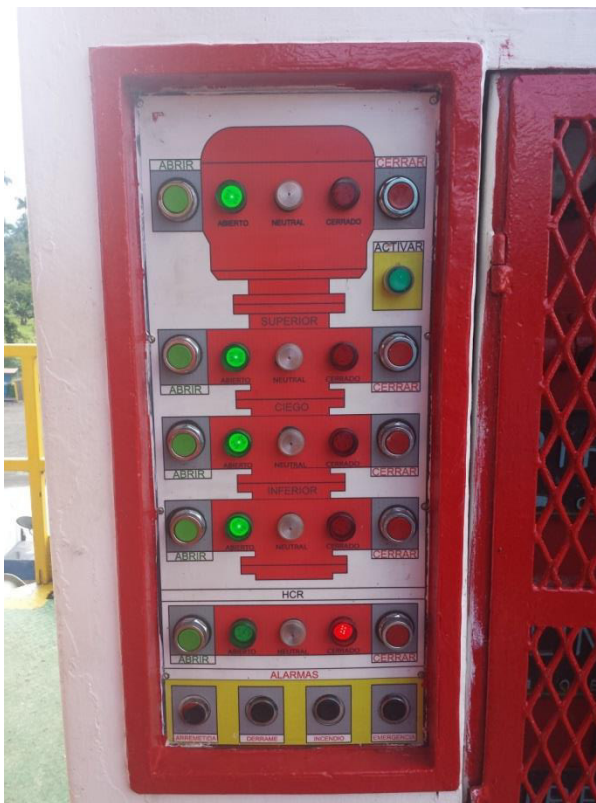
Figura 4.67. Instalación final Panel Remoto eléctrico en la Casa del Perro.
