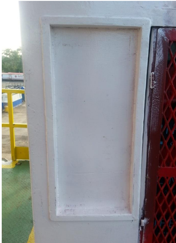
Figura 4.43. Instalación de panel fabricado.
