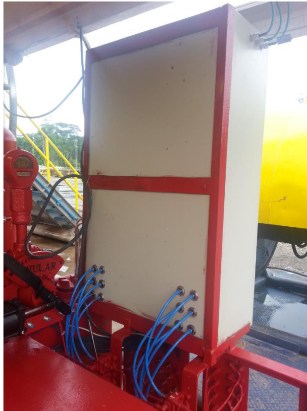
Figura 4.7. Instalación final del gabinete del acumulador de presión.
