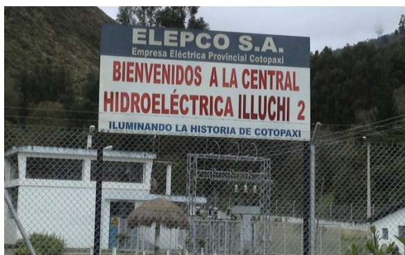
Figura 2.4: Casa de máquinas de la Central Illuchi N° 2
