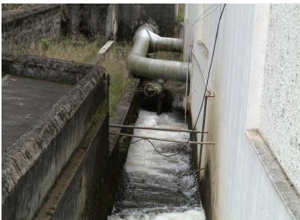
Figura 2.3: Canal de descarga de la Central Illuchi N° 2
